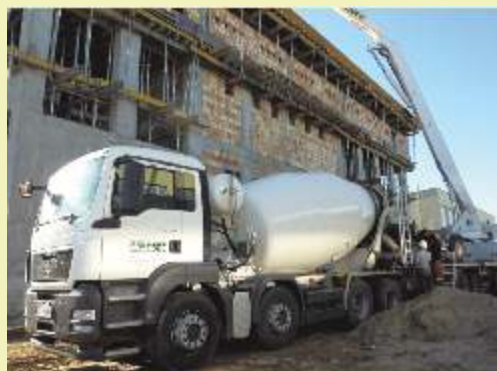
Betonomieszarki o pojemnościach 10m 3 , 9m 3 oraz 7m 3
