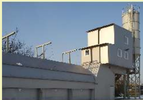
Węzeł betoniarski w Łomży
